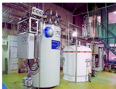
写真2-5-2-1 極低温室と現在のヘリウム液化装置
