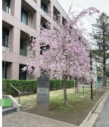
理学系総合研究棟 Science Research Building
