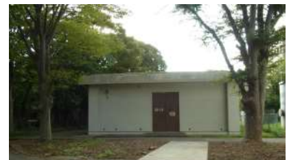
②受配電室
