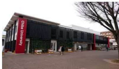
①低層事例 総合学生支援センター (2012年改修)
