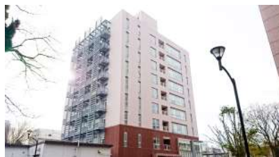
⑤高層事例 工学系総合研究棟2
