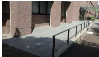
スロープ+点状ブロック
