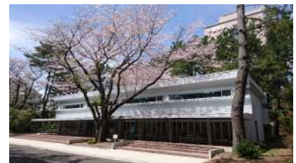
①松韻会館(2016年改修)
