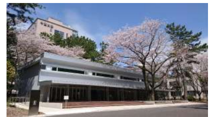
②低層事例 松韻会館 (2016年改修)
